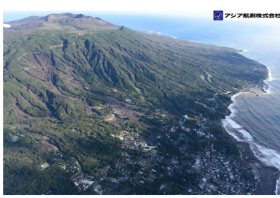
図-1: 2013年台風26号による伊豆大島の土砂災害
